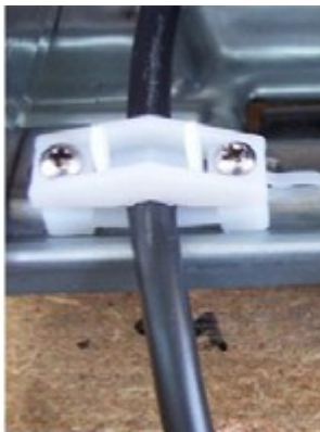
13. ábra: a kábel dupla bilincses rögzítése
